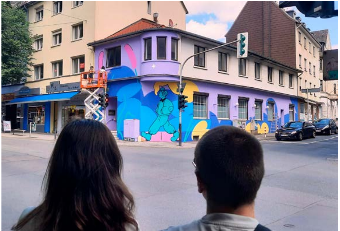
Abb. 2: Fassade der ehemaligen Fellowship-Residenz in Umgestaltung, Foto: Kulturforum Witten
