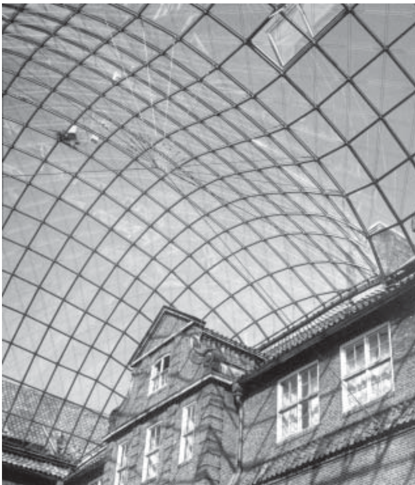
Ingenieur baukunst II Transparent, leicht und feingliedrig: Innenhofüberdachung des Museums für Hamburgische Geschichte. Ingenieure Jörg Schlaich und Volkwin Marg aus: ebd., S. 146
